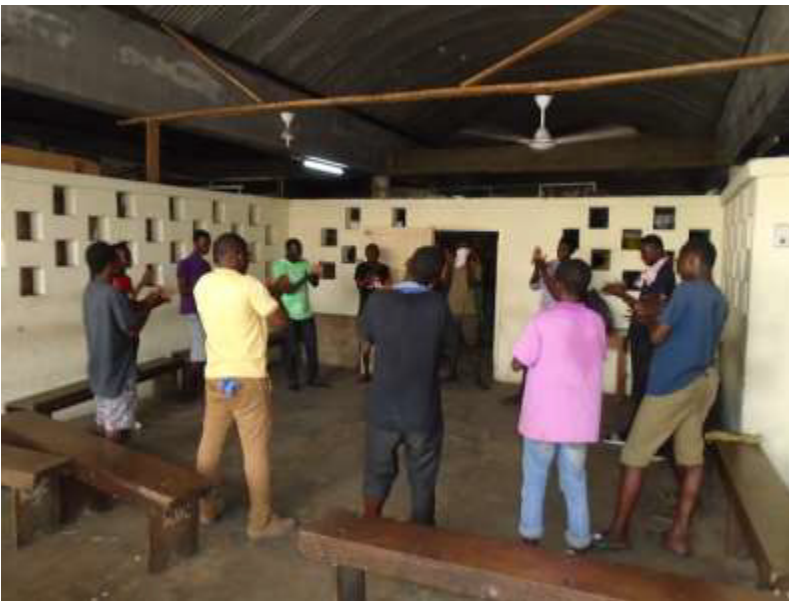
beschädigte Mauer im Refuge
