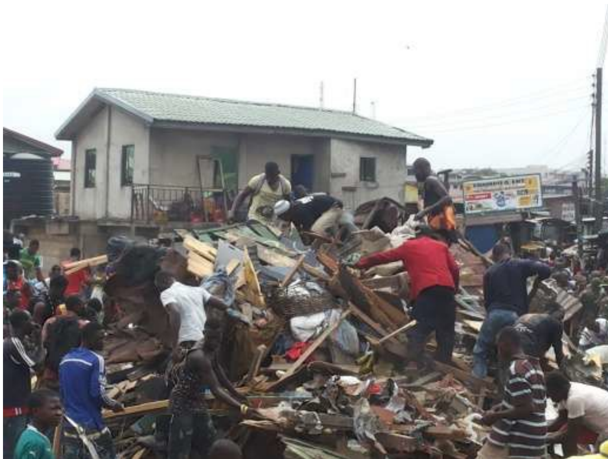
Teilweise Zerstörung von Old Fadama
